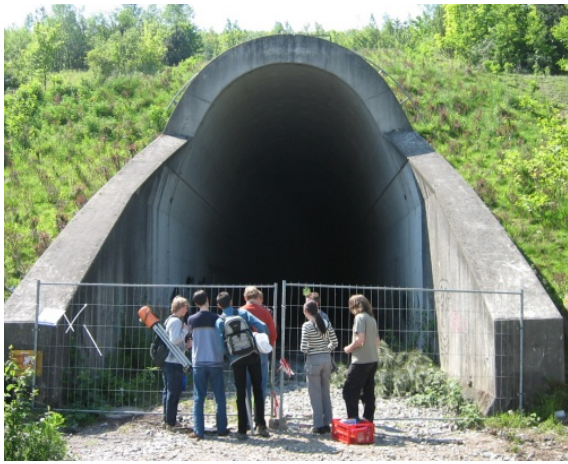
Abbildung 4: Vor dem Tunneleingang
