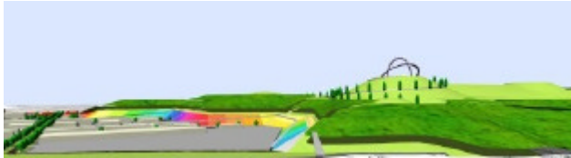
Abb. 2: Blick von der Nachbarhalde Hoppenbruch auf das Horizontobservatorium. Auch von den Bundesautobahnen A2 und A43 kann es gesehen werden.
